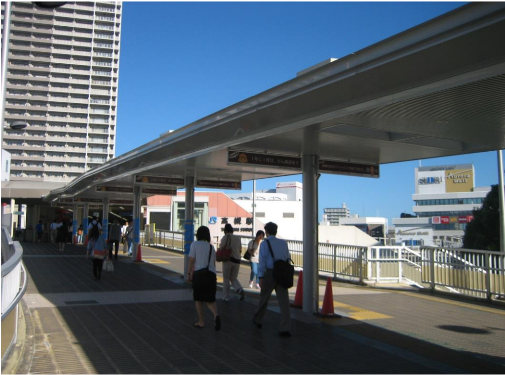
JR高槻駅南人工デッキ情報提供施設 写真
