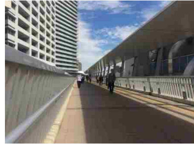
【JR高槻駅北側の人工デッキ整備】
