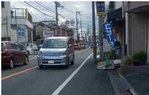
図 2-24 幹線道路における歩道未整備区間の例
