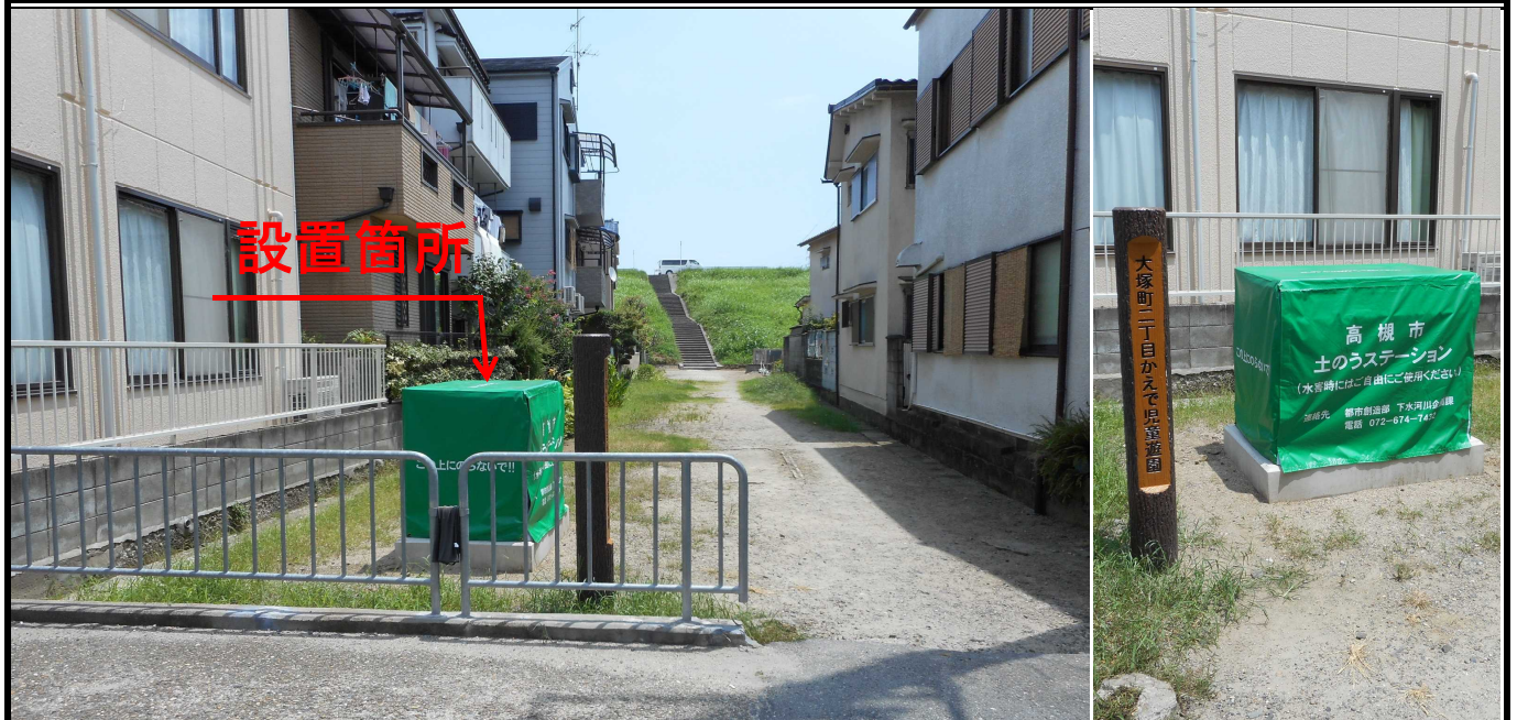
設置状況写真
