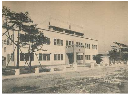
図1 竣工直後の高槻町役場新庁舎 （『第一回町会史』より）
