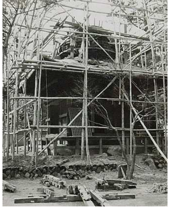
図6 移築のための解体作業の様子 (当館蔵。1960年2月撮影)
