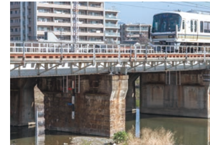
高槻城の石垣が再利用されたJR京都線の橋脚
