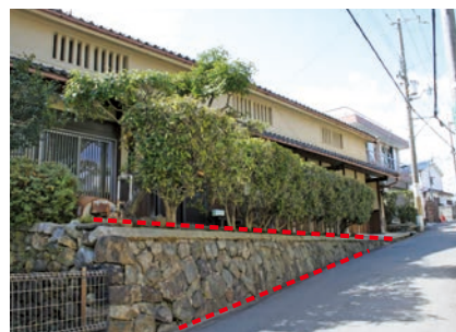
石垣を斜めに積んで家を築いているのは、高低差のある富田らしい建築方法である
