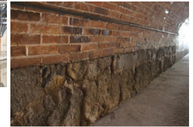
JR京都線沿線には石垣石を一部利用したトンネルが複数見られる
