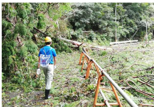
戸別運搬給水*の様子
