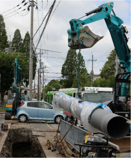
水道管工事の様子
