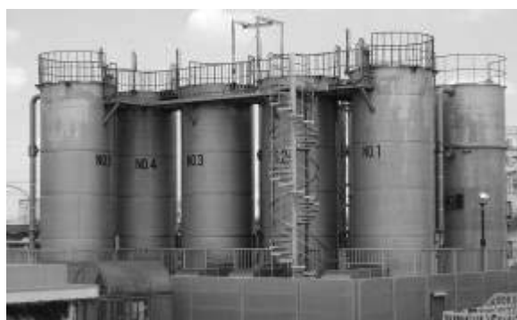
エアレーションタワー
