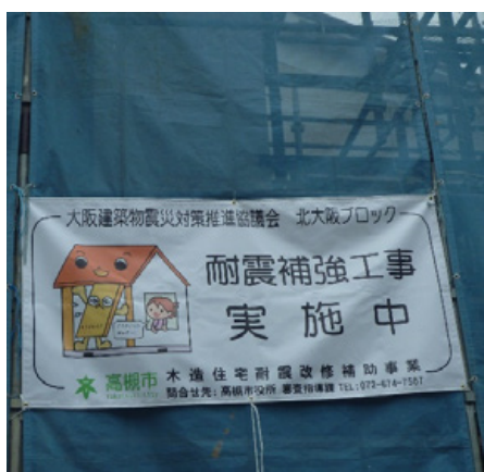
写真：工事現場の啓発養生幕
