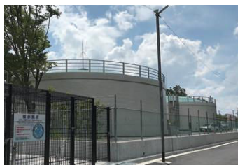
城山第1配水池
