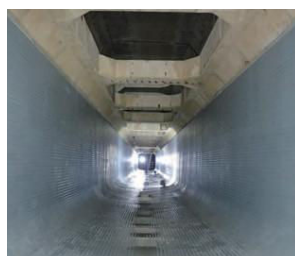
耐震工事後の下水道管の内部
