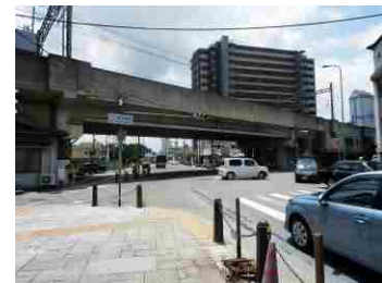
図 耐震化対象の鉄道高架橋（高槻市八丁畷交番前交差点付近）
