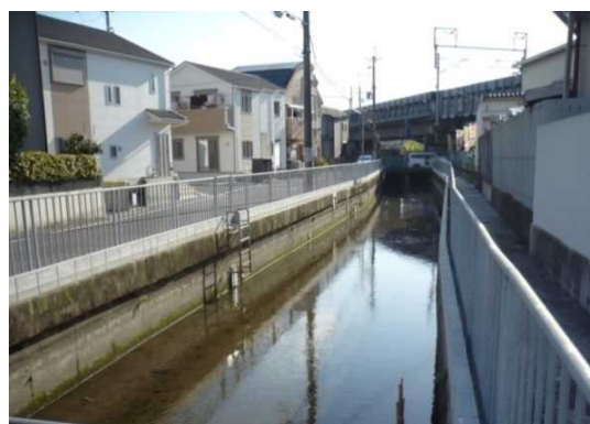
水路側壁のかさ上げ
