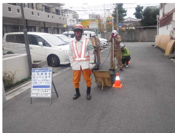
巡視点検の様子
