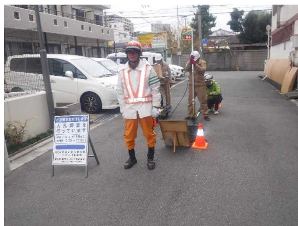
巡視点検の様子
