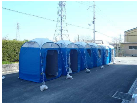
マンホールトイレ設置状況
