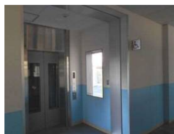
エレベーターの設置
