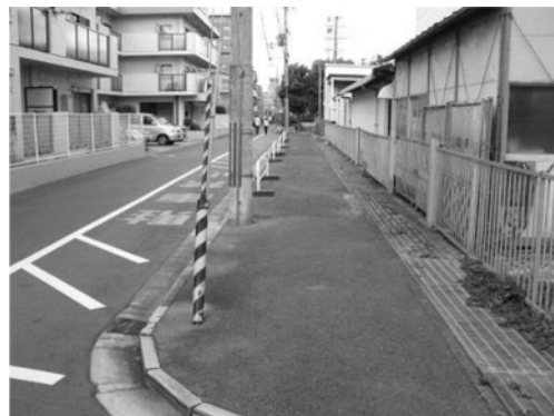
24南芥川町5号線の現況
