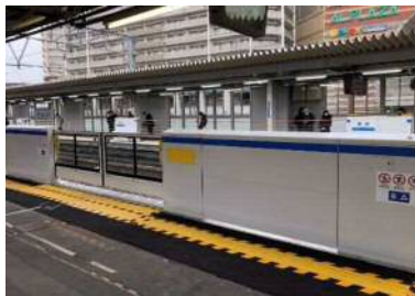
ホーム柵の設置
