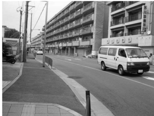
7 西京高槻線の現況
