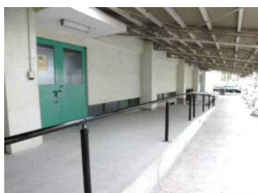
スロープ・手すりの整備
