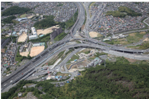
<平成 29 年に供用開始した高槻 JCT・IC> 新名神・名神の両高速道路へのアクセスが可能に
