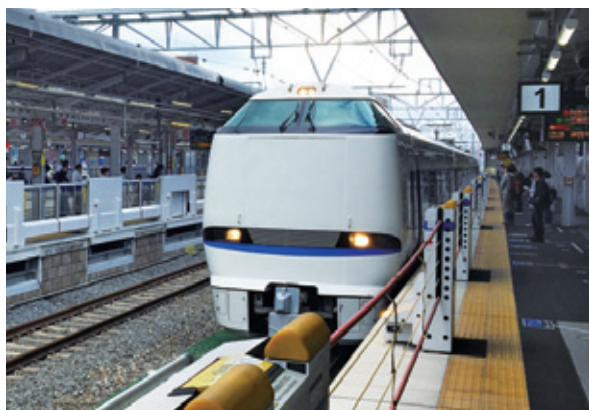
< JR 高槻駅 > ホームが新設され、全てのホームにホーム柵が設置 また、特急の停車も実現し、利便性が向上
