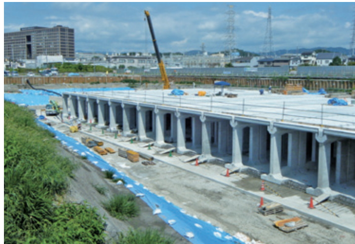
<雨水貯留施設> 集中豪雨の際、雨水を一時的に貯留し、浸水被害を軽減。安満遺跡公園、高槻城公園内に整備
