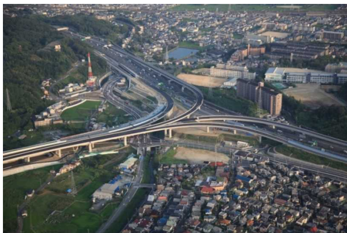
新名神高速道路高槻ジャンクション・インターチェンジの整備を契機とした新たな企業誘致の推進 （提供：西日本高速道路株式会社）
