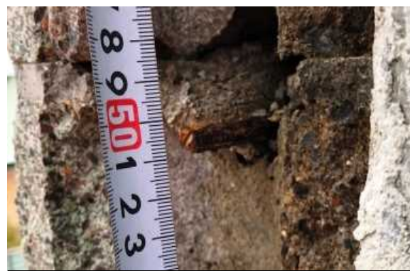
横筋の腐食
