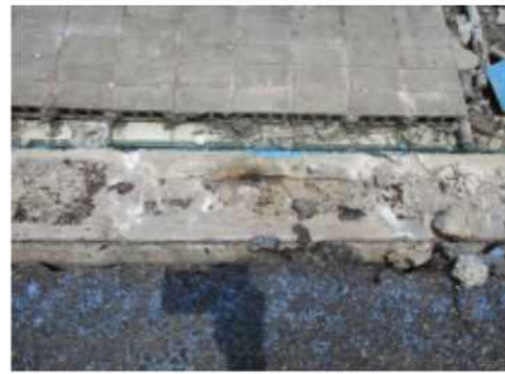
【14】 破断 破断長さ:10mm未満
