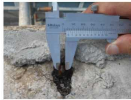
【11】 破断 減厚後の径 5mm
