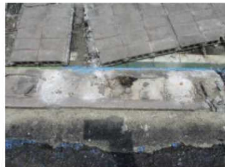
【8】破断 破断長さ:10mm
