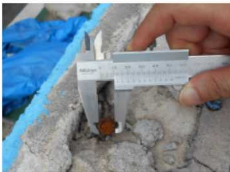
【8】 破断 減厚後の径 12mm
