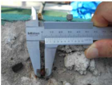
【15】 破断 減厚後の径 5mm
