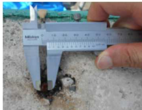
【17】 破断 減厚後の径 6mm
