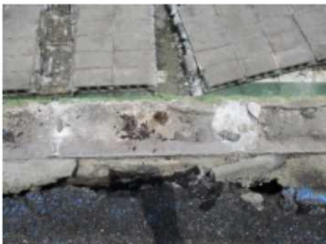
【7】破断 破断長さ:20mm
