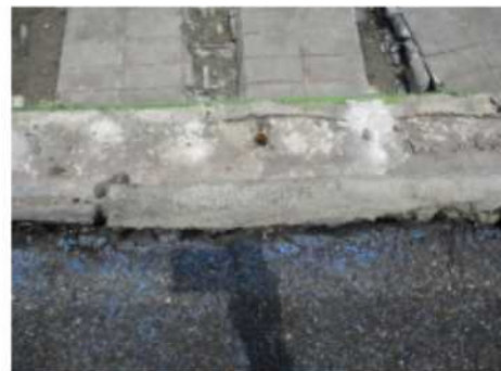
【6】破断 破断長さ:25mm
