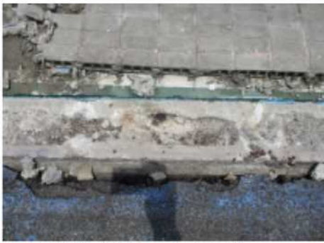
【13】 破断 破断長さ:10mm未満
