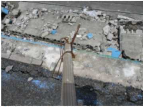
【25】 上抜け 接合筋長さ:255mm
