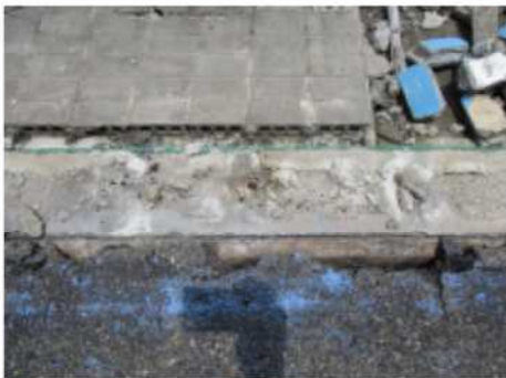
【15】 破断 破断長さ:10mm未満
