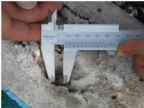
【13】 破断 減厚後の径 9mm
