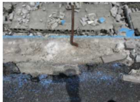
【24】 上抜け 接合筋長さ:245mm
