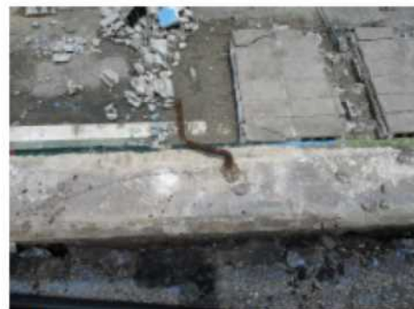
【4】上抜け 接合筋長さ:225mm
