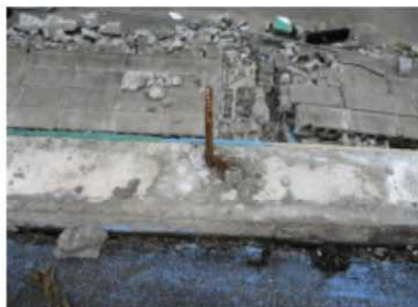
【41】上抜け 接合筋長さ:165mm
