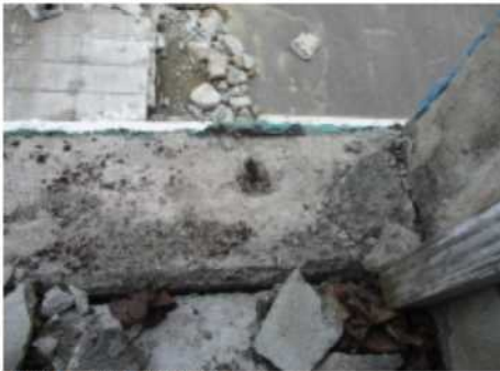
【46】 破断 破断長さ:35mm
