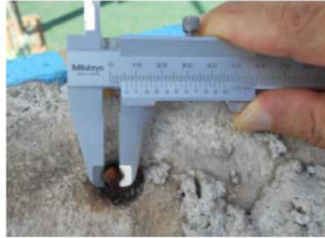
【20】 破断 減厚後の径 6mm
