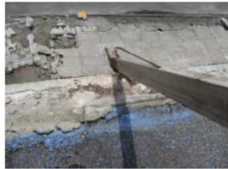
【12】 上抜け 接合筋長さ:270mm
