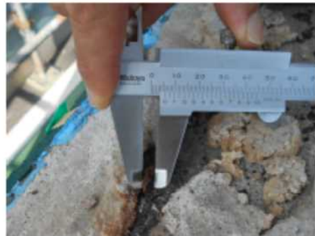
【14】 破断 減厚後の径 6mm
