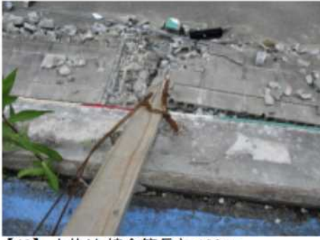
【42】 上抜け 接合筋長さ:180mm
