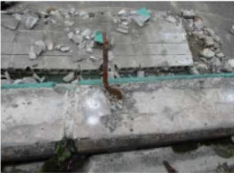
【44】 上抜け 接合筋長さ:200mm
