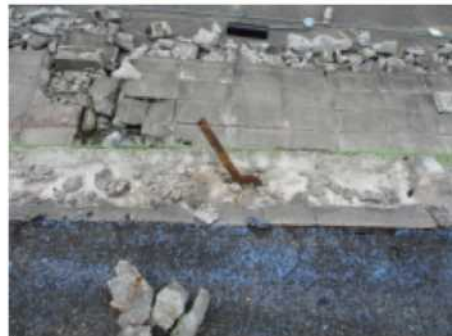
【38】上抜け 定着筋長さ:145mm
