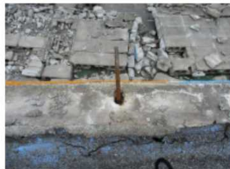
【33】 上抜け 接合筋長さ:235mm
