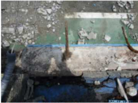
【1】上抜け 接合筋長さ:230mm
