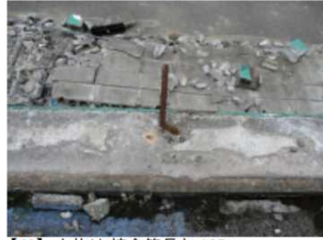
【43】 上抜け 接合筋長さ:165mm
