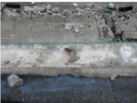
【40】破断 破断長さ:40mm
