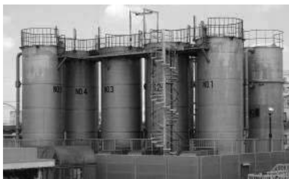
エアレーションタワー
