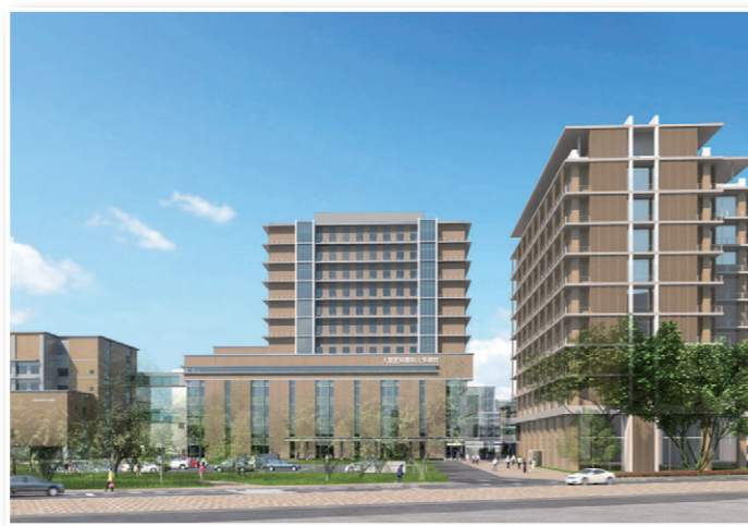
▲新本館A棟（中央）1階に整備される救命救急センター（イメージ）
