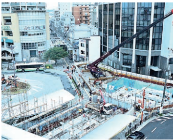
JR高槻駅北駅前広場の 雨水貯留施設の整備
