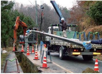
水道管の更新工事
