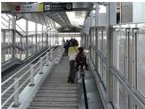
図3-47 サイクルコンベア(弁天こ線橋)
