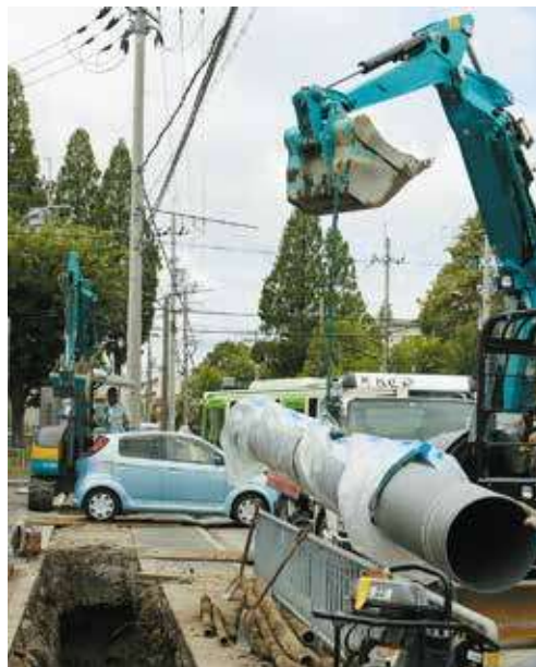
水道管工事の様子
