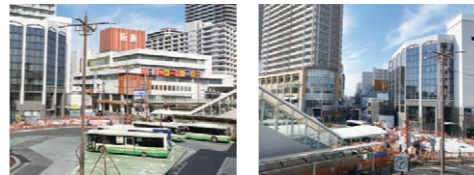
工事の様子(2/12撮影)
