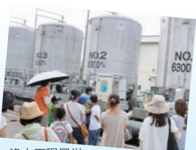
浄水工程見学
