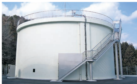
阿武山配水池2号池
