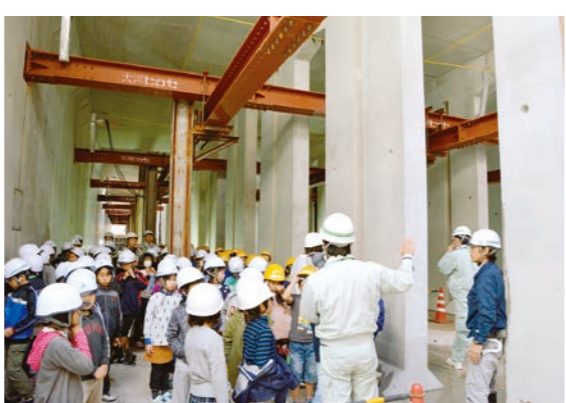
👦 高槻小学校児童が 建設中の雨水貯留施設を見学
