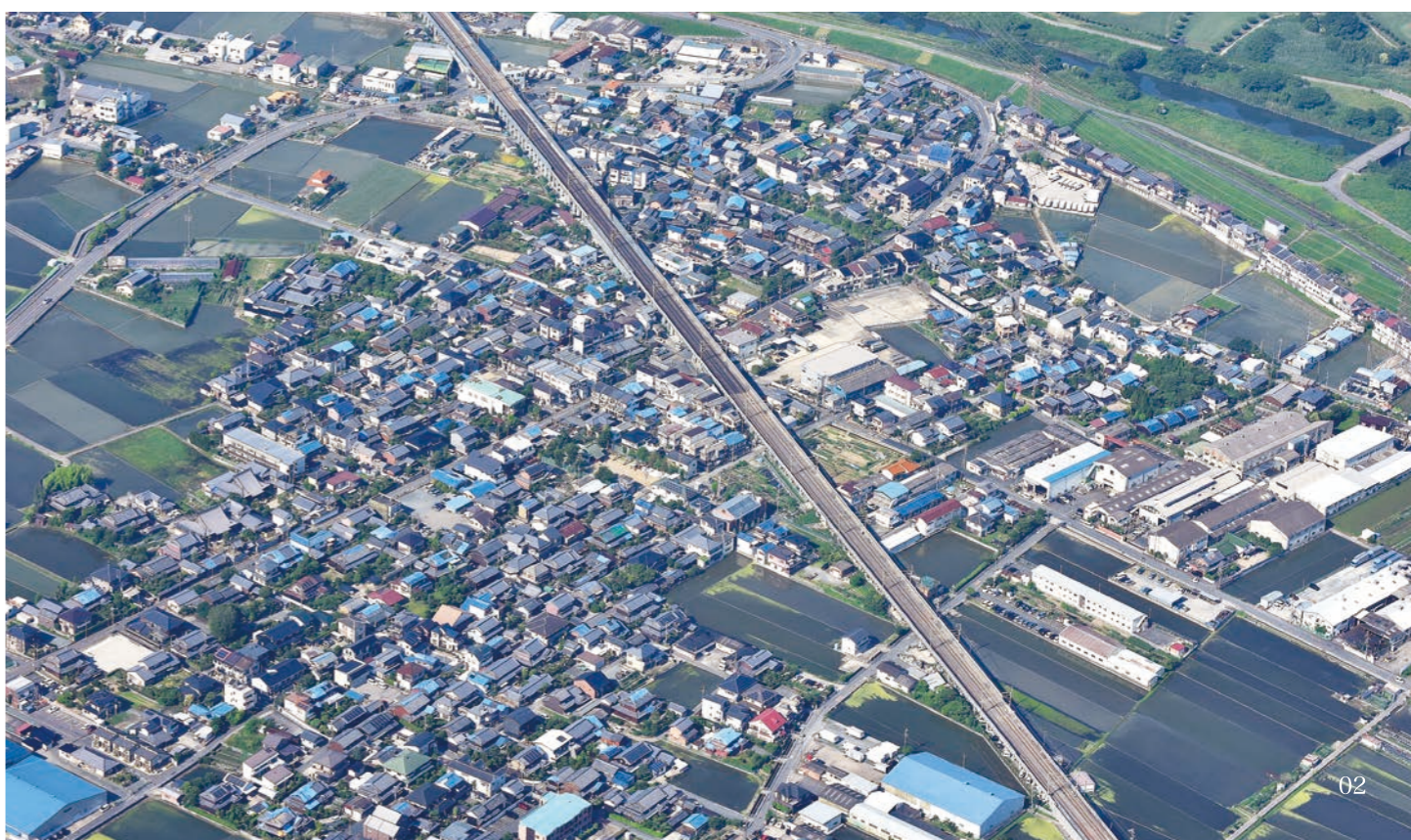
屋根瓦が落ちるなどの被害が多数発生し、ブルーシートでの応急処置が見られた(6月25日)
