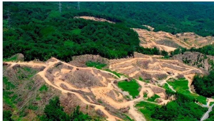
図 工事が中断したメガソーラー計画地 (奈良県平群町) 出典：YAHOOニュース
