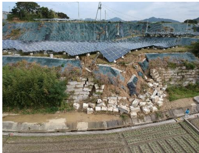
図 大雨による造成地の崩落事故
