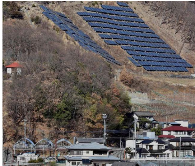
図 住宅地近郊の森林を伐採して斜面に設置された事例（山梨県） （出典：甲府新聞）
