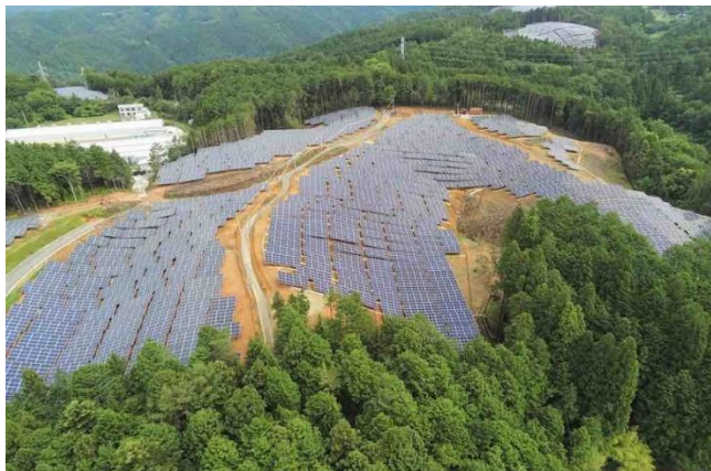
図 山林に設置された太陽光発電施設 (出典：名古屋大学)
