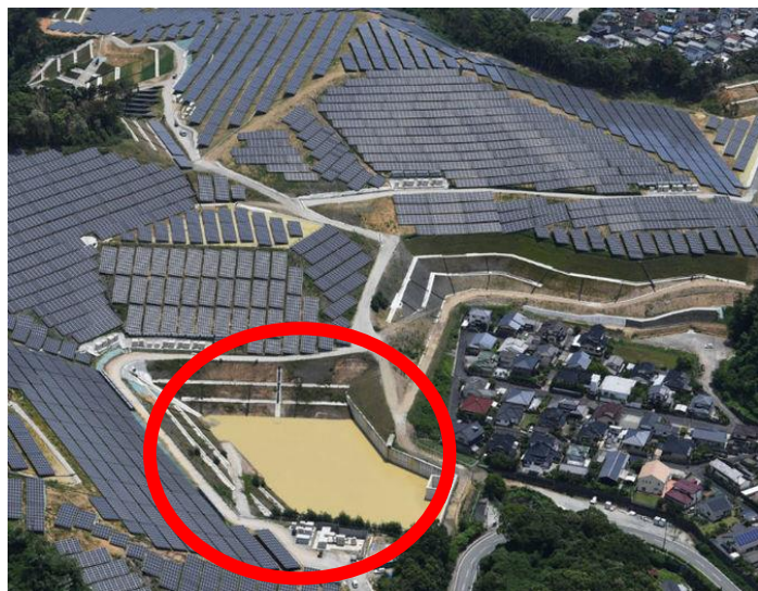
図 太陽光発電施設からの発生する濁水
