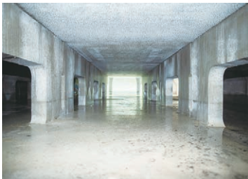
JR高槻駅北の雨水貯留施設
