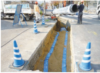
水道管路耐震化工事
