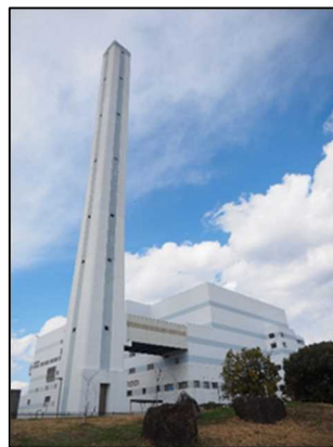
写真 エネルギーセンター第3工場
