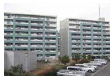
耐震化工事を実施したマンション
