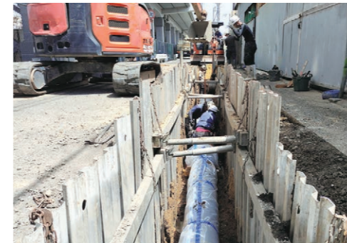
管路の更新工事
