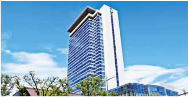
▲(仮称)総合防災センターが整備される総合センター
