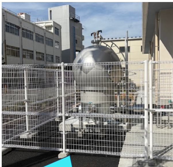
<水道部庁舎南側に設置した貯水機能付給水管>
