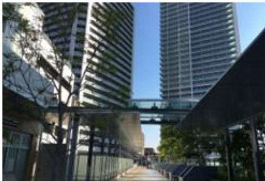
JR高槻駅北東地区
