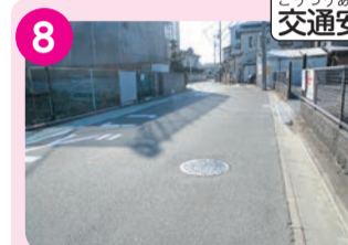
8 交通安全 道幅がせまい。交通量が多 い。減速しないまま 通行する車が多く、注意が 必要。
