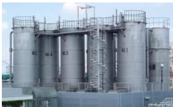
エアレーションタワー
