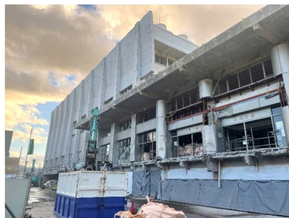
市民会館解体状況（令和5年11月）
