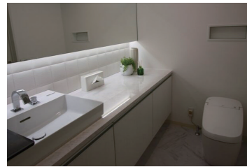
トイレリフォーム
