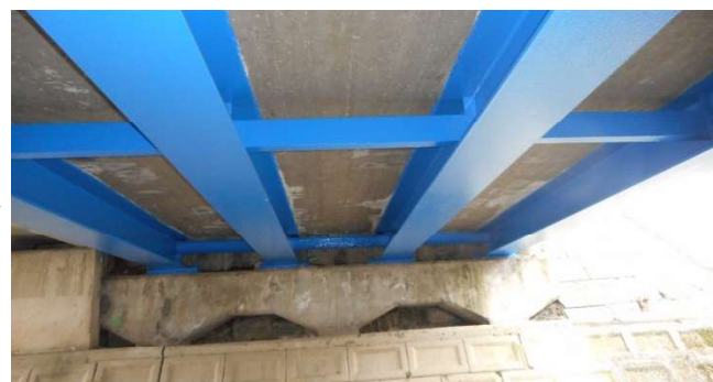
〔措置後〕塗替え塗装工
