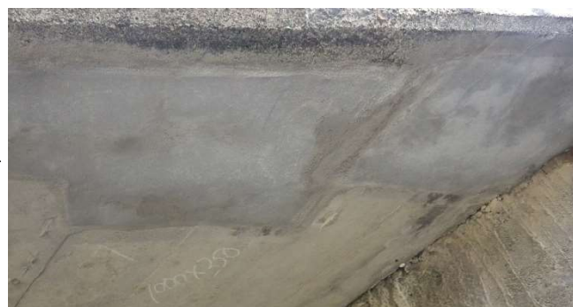
〔措置後〕断面修復工
