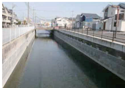
農業用排水路整備
